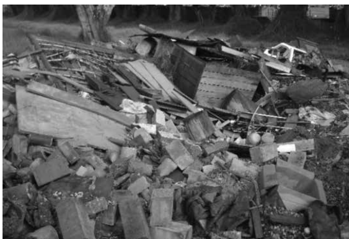
Foto 1. Residuos de construcción y demolición
